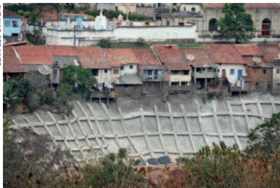
Muro de contenção da Rua do Carvalho abrigará Rua da Música
