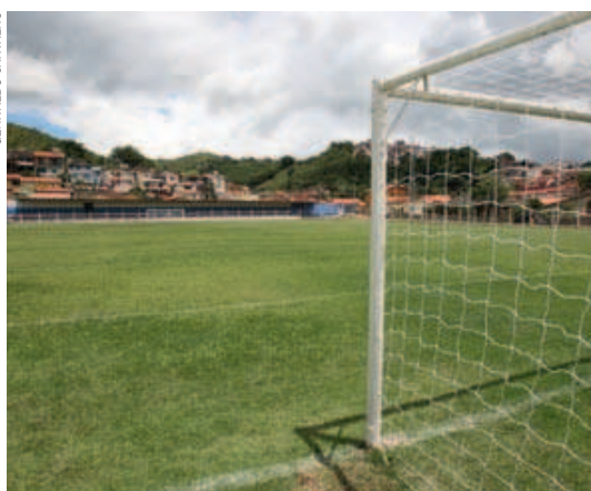
Danificado pelas chuvas, o estádio de futebol está sendo remodelado
