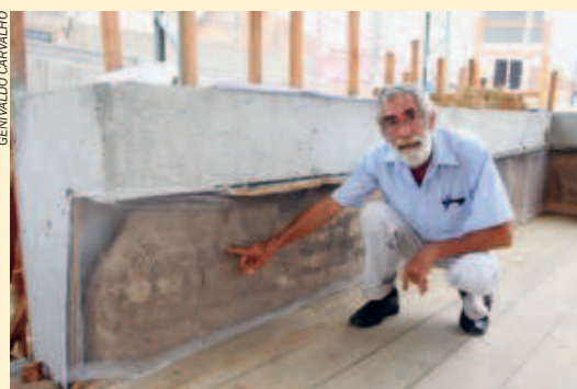
Arquiteto Gameiro e a janela de vidro que revela a antiga construção
