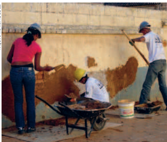
Obra do Sesi: curso de capacitação em trabalhos de restauração
