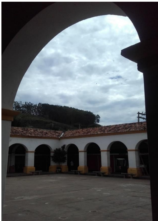
VISTA EXTERNA DO TELHADO – 1
