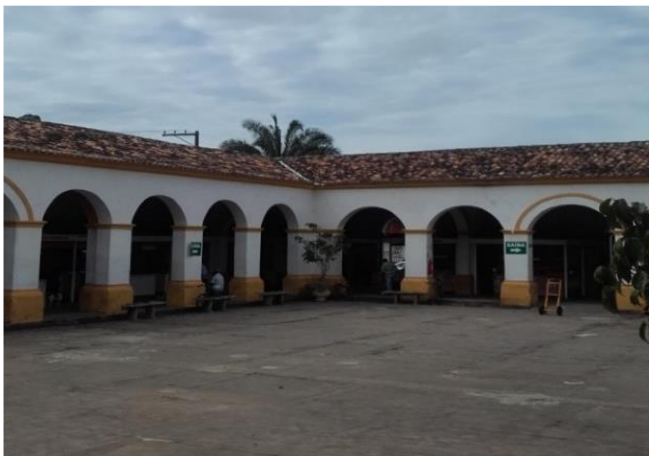
VISTA EXTERNA DO TELHADO – 2
